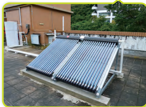
Solar Water Heater 太陽能熱水系統
