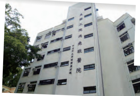
東華三院馮堯敬醫院 TWGHs Fung Yiu King Hospital
