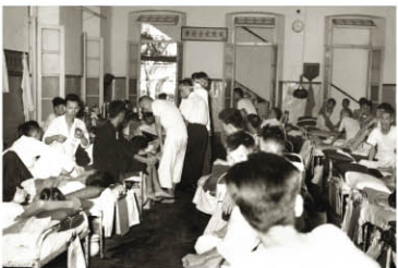
廣華醫院重建前病房內非常擠迫。
