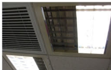
本院行政總部的節能裝置：（左）T5光管有較高的發光效率，光管的數量可相對減少，從而達致雙重節能效果。其他設施還有（中）動作感應器及（右）二極管出路燈。
