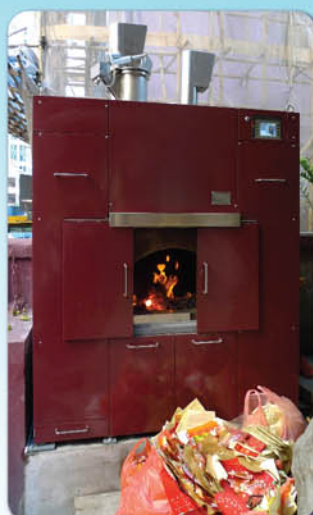
灣仔洪聖廟採用內置乾式煙霧緩減系統的化寶爐。
